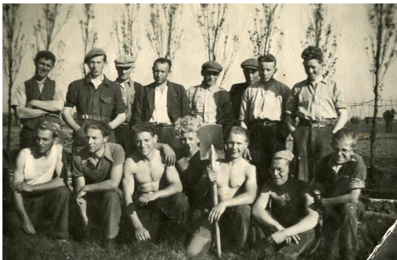
Op de foto 15 mannen tijdens de aanleg van het VFC-complex.
